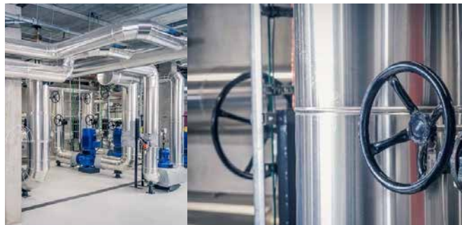
Zawory kulowe BROEN BALLOMAX kontrolujące przepływ wody grzewczej
