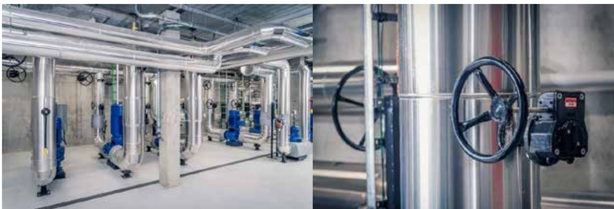
Zawory kulowe BROEN BALLOMAX kontrolujące przepływ wody grzewczej.
