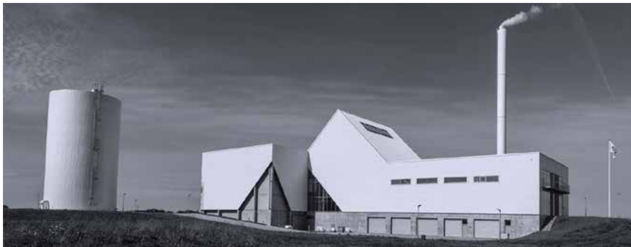
Instalacja ciepłownicza w Aabybro (Dania).
