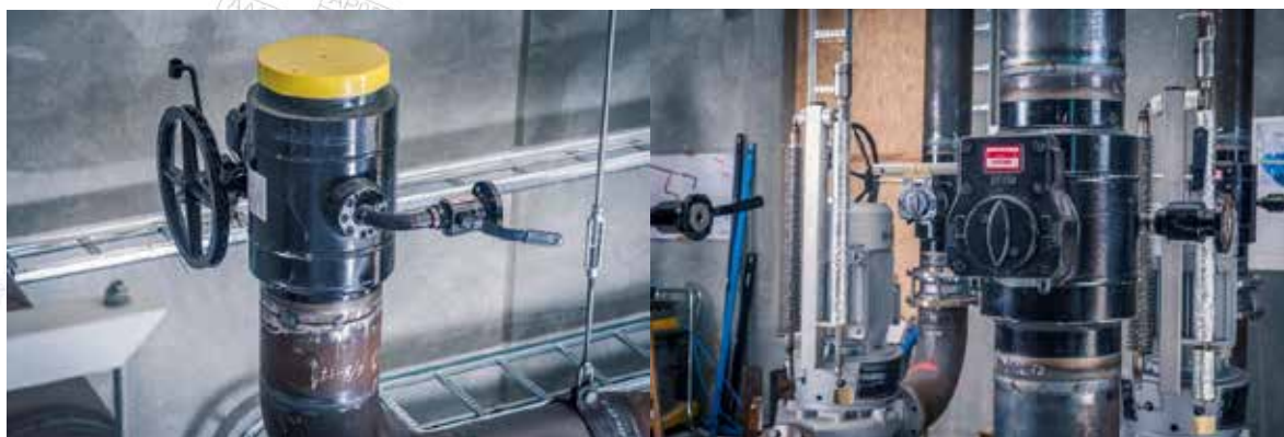
BROEN BALLOMAX DN250-DN400, zawory kulowe podwójnie łożyskowana, Double Bloch and Bleed i spustem podczas spawania w Ciepłowni w Habro.
