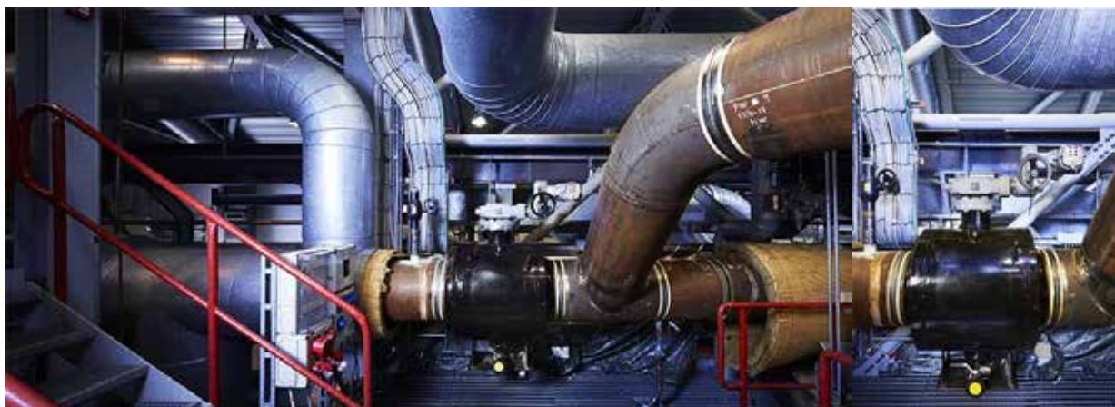
BROEN BALLOMAX - podwójnie łożyskowany zawór z kulą jarzmioną, double block and bleed DBB, ze spustem w korpusie zaworu.
